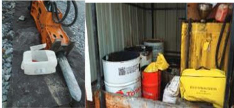
Exemple d'une aire de stockage des matériaux dans un container étanche associé à un kit anti-pollution. Certains produits sont isolés du sol et disposés sur des bacs de rétention ou géotextile absorbant (source : AFB)
